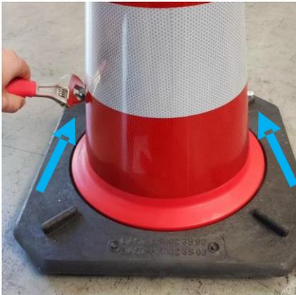
Außen die beiden Muttern mit einem 13 Ring-/Maulschlüssel lösen.
